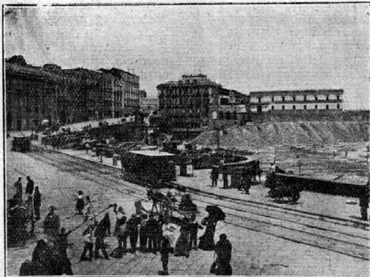
Fig. 21. Napoli — S. Lucia — Le colmate con terra di scarico
